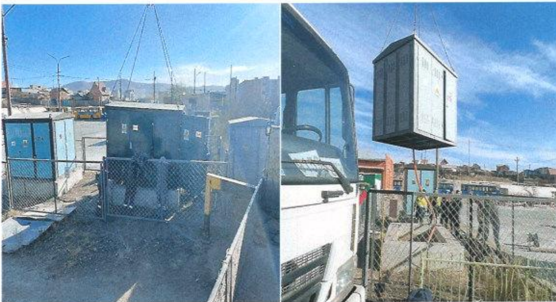
Зураг 6. Цахилгаан дэд станц суурилуулах явц
