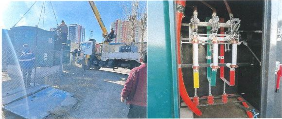
Зураг 7. Цахилгаан дэд станц суурилуулах явц
