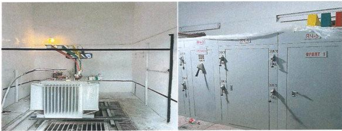
Зураг 8.Цахилгаан дэд станц суурилуулах явц
